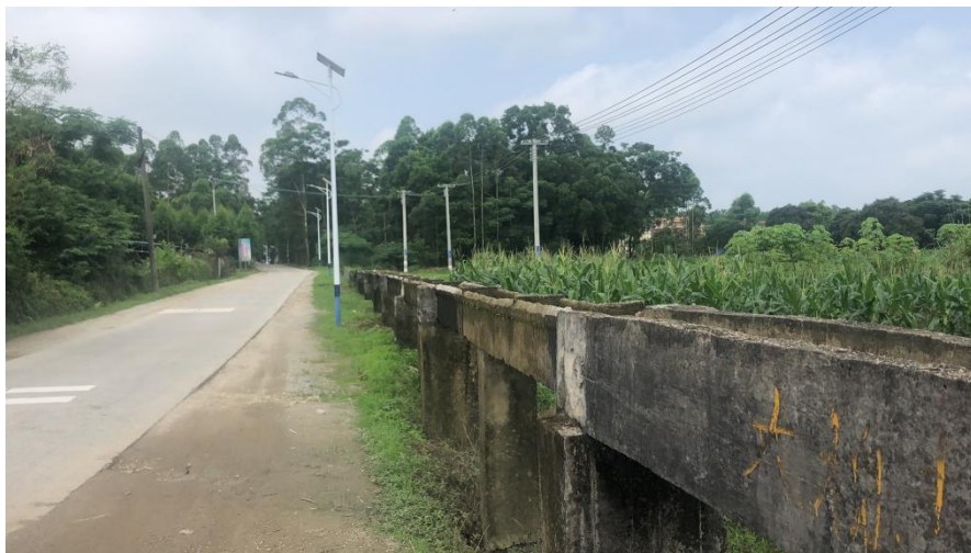
现状路边架空引水渠（起点处往那吉镇方向）
