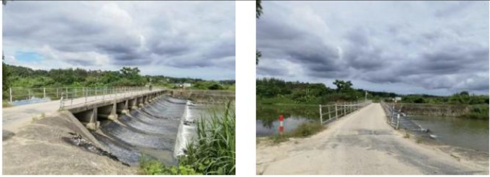
K2+330 现状锦岭漫水桥
