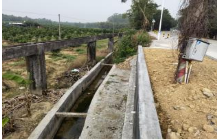
现状路边灌溉沟及架空引水渠（起点处往省道 S367 方向）
