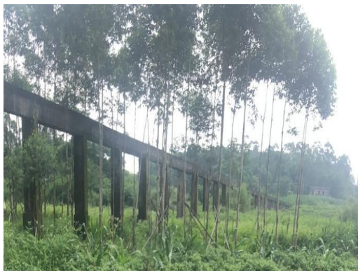
现状农业灌溉引水渠（锦岭村附近）
