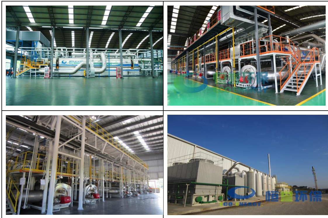
图 2-2 部分工程实例现场照片
